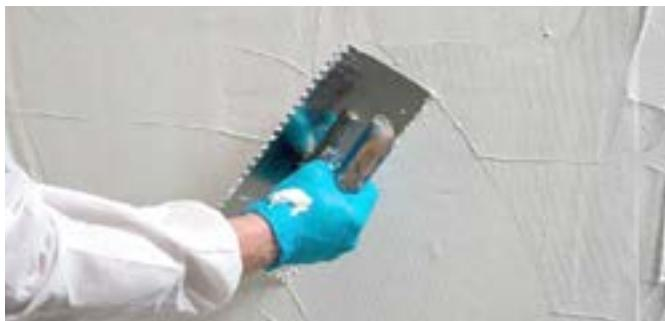
**4** Das KÖSTER Armierungsgewebe wird in die Oberfläche der ersten Lage eingebettet. Danach wird die zweite Lage KÖSTER Thermo-Sanierputz aufgetragen.
