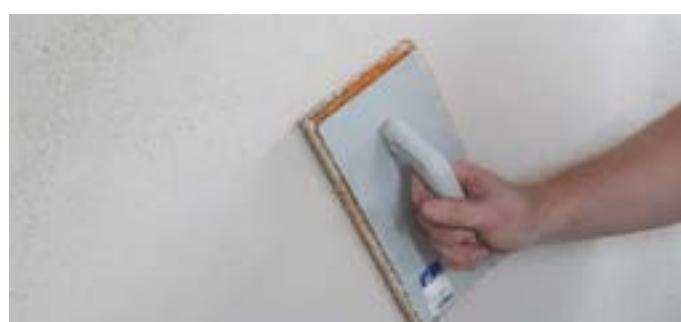
**5** Nach ausreichendem Anziehen wird der Putz mit einem Holz- oder Kunststoffbrett abgerieben und abschließend mit einem Schwammbrett überarbeitet.
