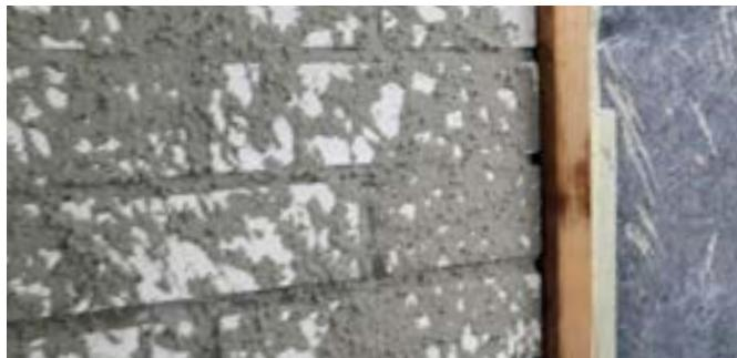
**2** KÖSTER Sanierputz Spritzbewurf wird in einer Schichtdicke von max. 5 mm bei einer Deckung von 50 % aufgespritzt oder angeworfen.
