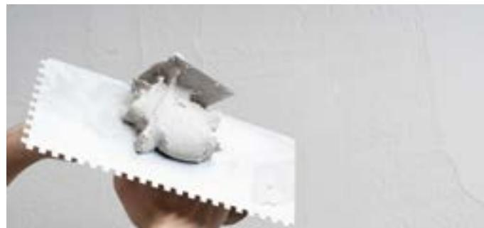
**3** KÖSTER Thermo-Sanierputz wird zu einem verarbeitungsfähigen Mörtel gemischt. Danach wird die erste Lage angeworfen und egalisiert.
