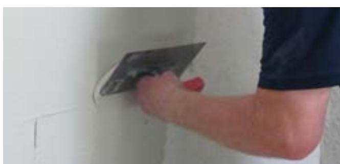
**6** Zur Oberflächenglättung kann der KÖSTER Feinspachtel in einer Schichtdicke bis 2 mm aufgetragen werden.
