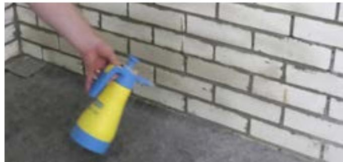
**1** Nachdem tiefen Ausbrüche mit KÖSTER Sperrmörtel ausgeglichen wurden, erfolgt die Grundierung mit KÖSTER Polysil TG 500.
